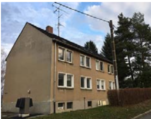
Abb. 39: Gebäude vor Sanierung mit Wärmepumpen-Außenluft-Einheit
