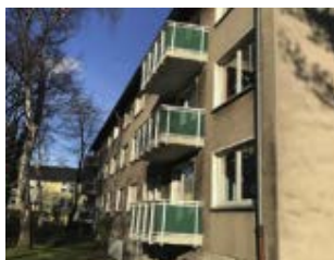
Abb. 48: Gebäude vor Sanierung
