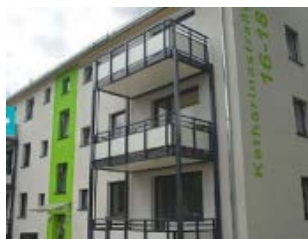
Abb. 49: Gebäude nach Sanierung
