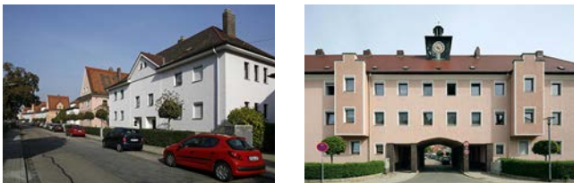
Abb. 61 und 62: Zwei Gebäude vor (li.) und nach der Sanierung
