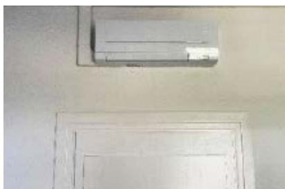
Abb. 41: Inneneinheit des Splitgeräts
