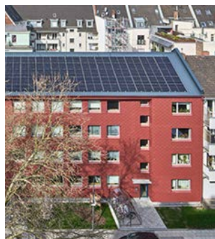
Abb. 66: Gebäude nach der Sanierung
