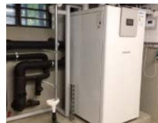
Abb. 51: Sole-Wasser-Wärmepumpe
